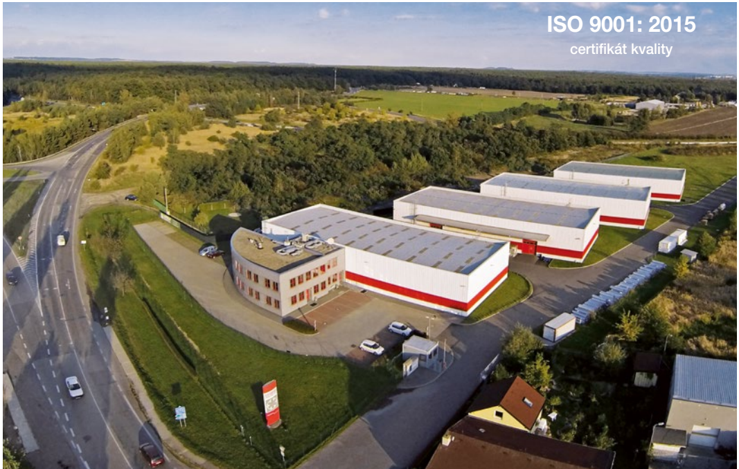
Logistický areál ELEKTRODESIGN ventilátory s.r.o. ve Staré Boleslavi v prostoru mezi dálnicí E65/D10 a vnitřní komunikací do Staré Boleslavi.
